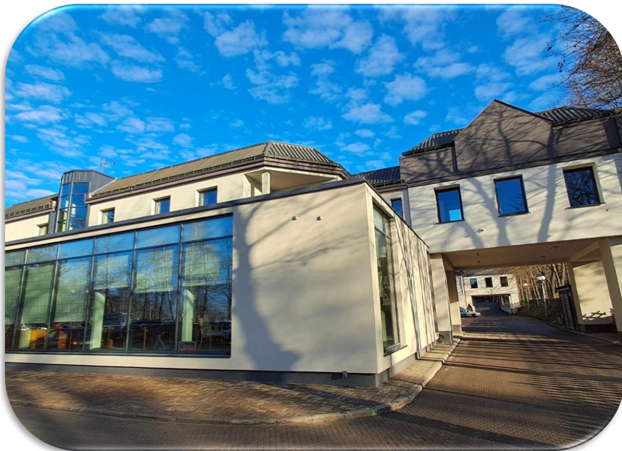
Budynek przy ul. Jeziornej 1A w Komornikach
