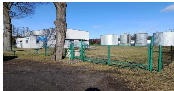
Stacja Uzdatniania Wody Wiry
