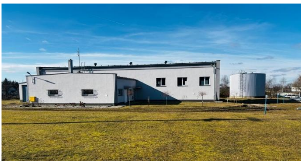
Stacja Uzdatniania Wody Szreniawa
