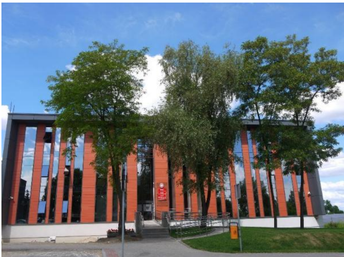
Rysunek 4 Budynek Urzędu Gminy w Komornikach
