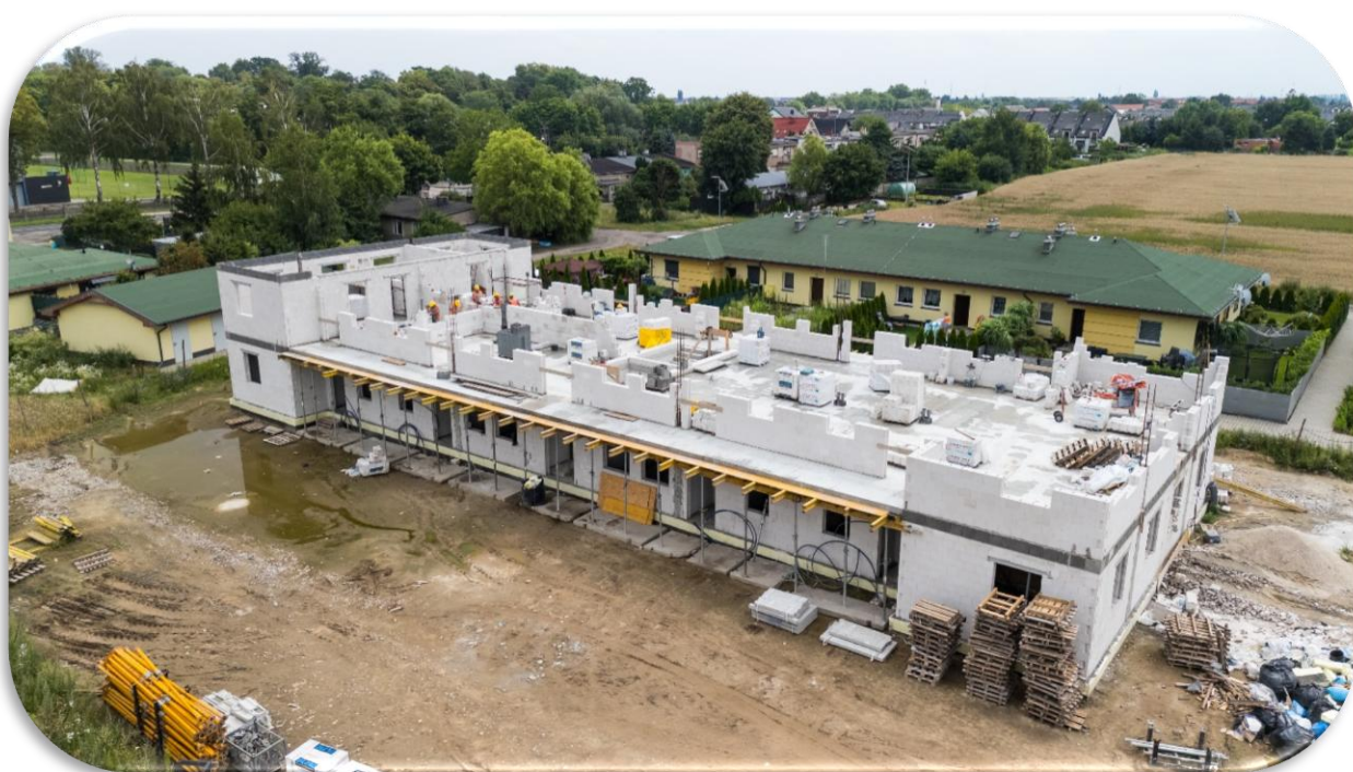
Budynek komunalny w Plewiskach – budowa
