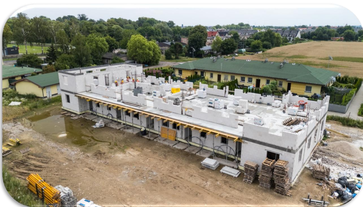
Budynek komunalny w Plewiskach – budowa
